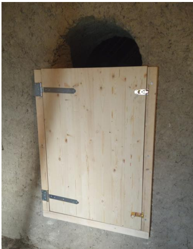
Welfrange: Einbau Tür zwischen Turm und Schiff
