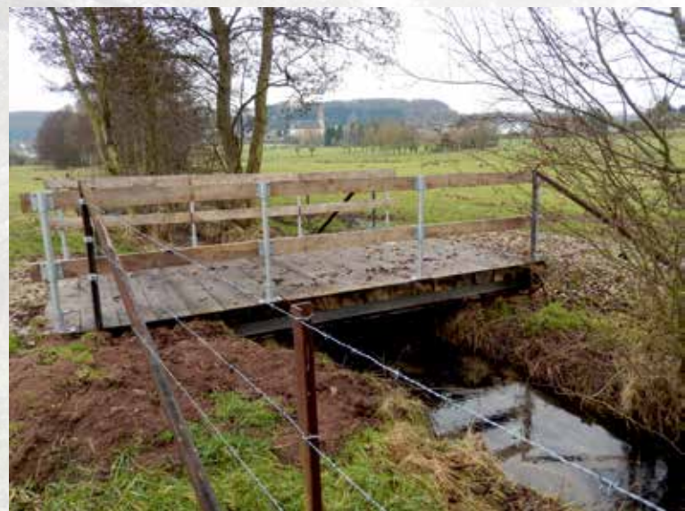
Die neue Überfahrt garantiert zum einen die Möglichkeit, den „Aalbaach“ zu überqueren, auf der anderen Seite bleibt das Gewässer passierbar für Fische. Le nouveau pont permet de franchir le cours d'eau aux véhicules et rend également possible la libre circulation des poissons.
